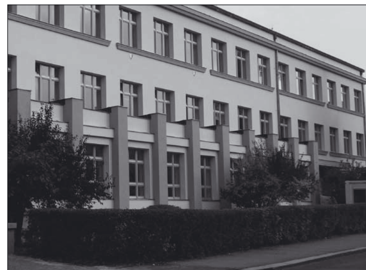
V budově dnešní ZŠ v ulici 28. října probíhalo vyučování studentů reálného gymnázia (z reálky se stalo reálné gymnázium v roce 1933) za války (v letech 1943 až 1945), kdy budova na Výšince sloužila jako vojenský lazaret
